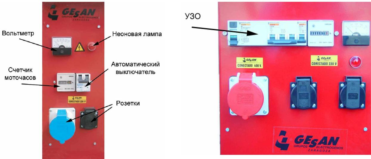
4. Контрольная панель + устройство защитного отключения (УЗО).
